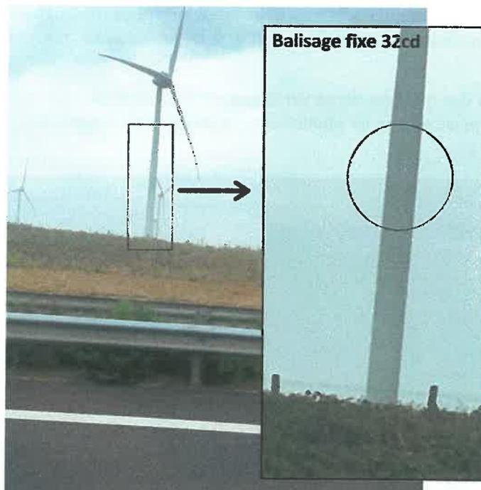
En ce qui concerne les éclats lumineux ils possèdent des caractéristiques bien précises. Les feux installés sur les éoliennes d'un même parc sont de même fréquence et sont **synchronisés**. La séquence d'allumage est initiée à 0 heure 0 minute 0 seconde du temps coordonné universel avec une tolérance admissible de 50 ms. Cette mesure évite le phénomène de clignotement déphasé dans le cas du parc éolien de La Naulerie qui est composé de deux éoliennes.
